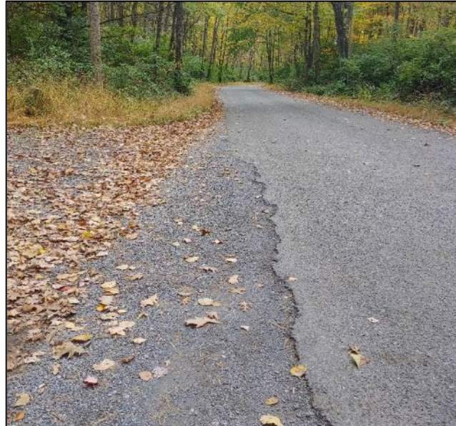
Edge cracking
